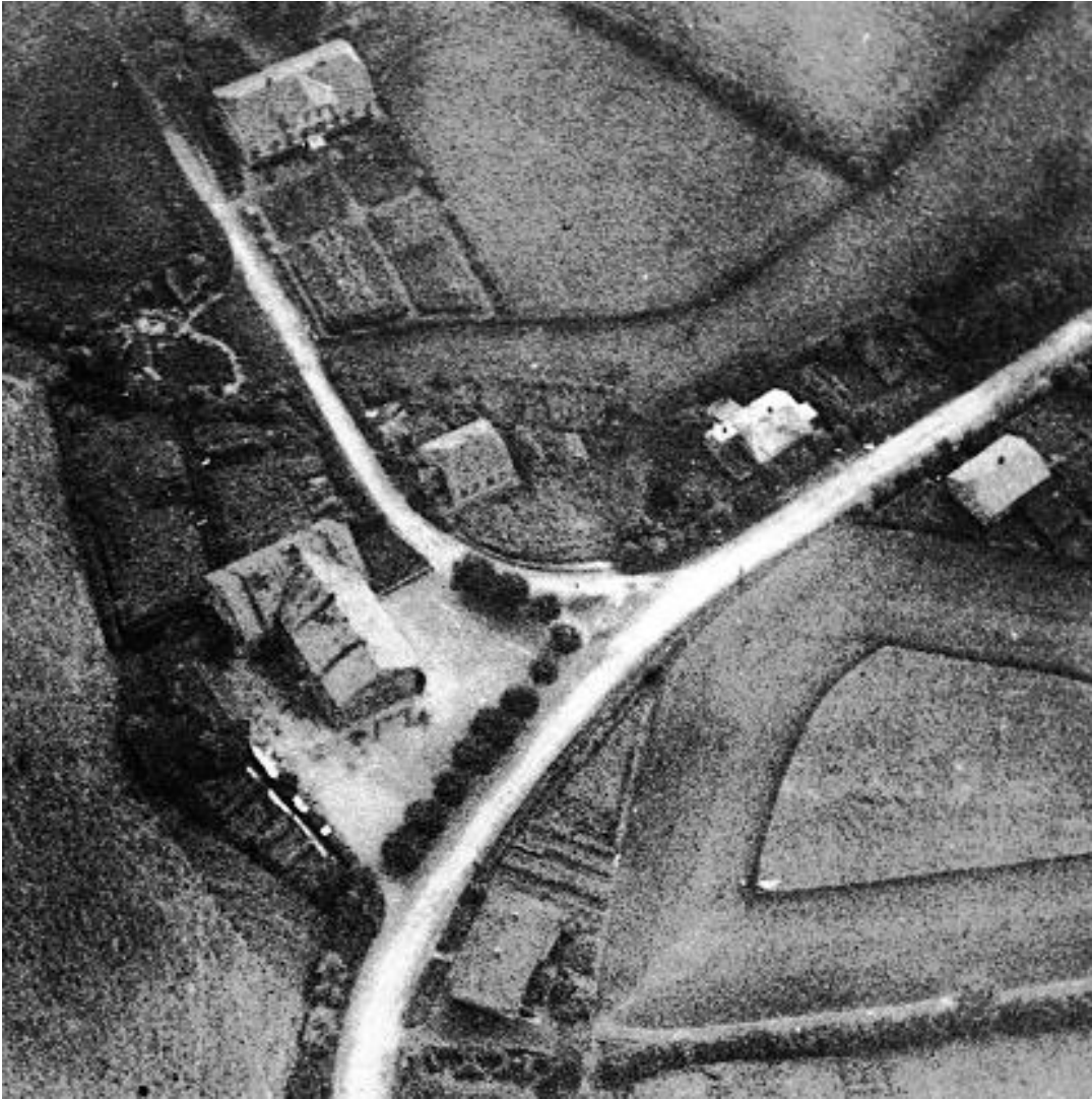
Das älteste Bild der Schule in Mohrkirch-Osterholz, eine Luftaufnahme von vor 1918
