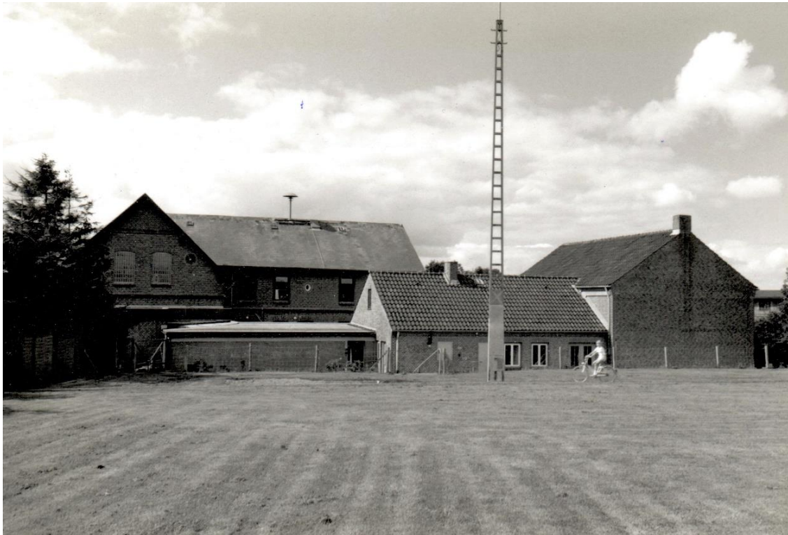
Blick über den Sportplatz von Norden auf die Nebengebäude und die Sporthalle
