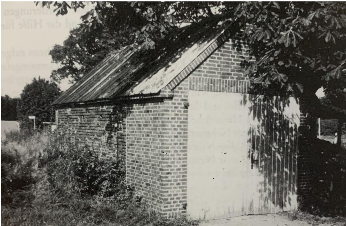
Altes Spritzenhaus bei Mohrkirch-Krug
