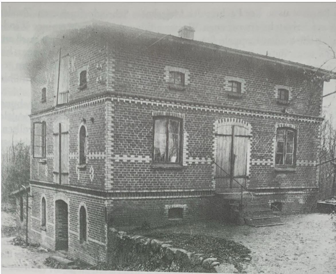
Die älteste Aufnahme der Wassermühle, die wir haben. Sie wurde um 1925 gemacht.
