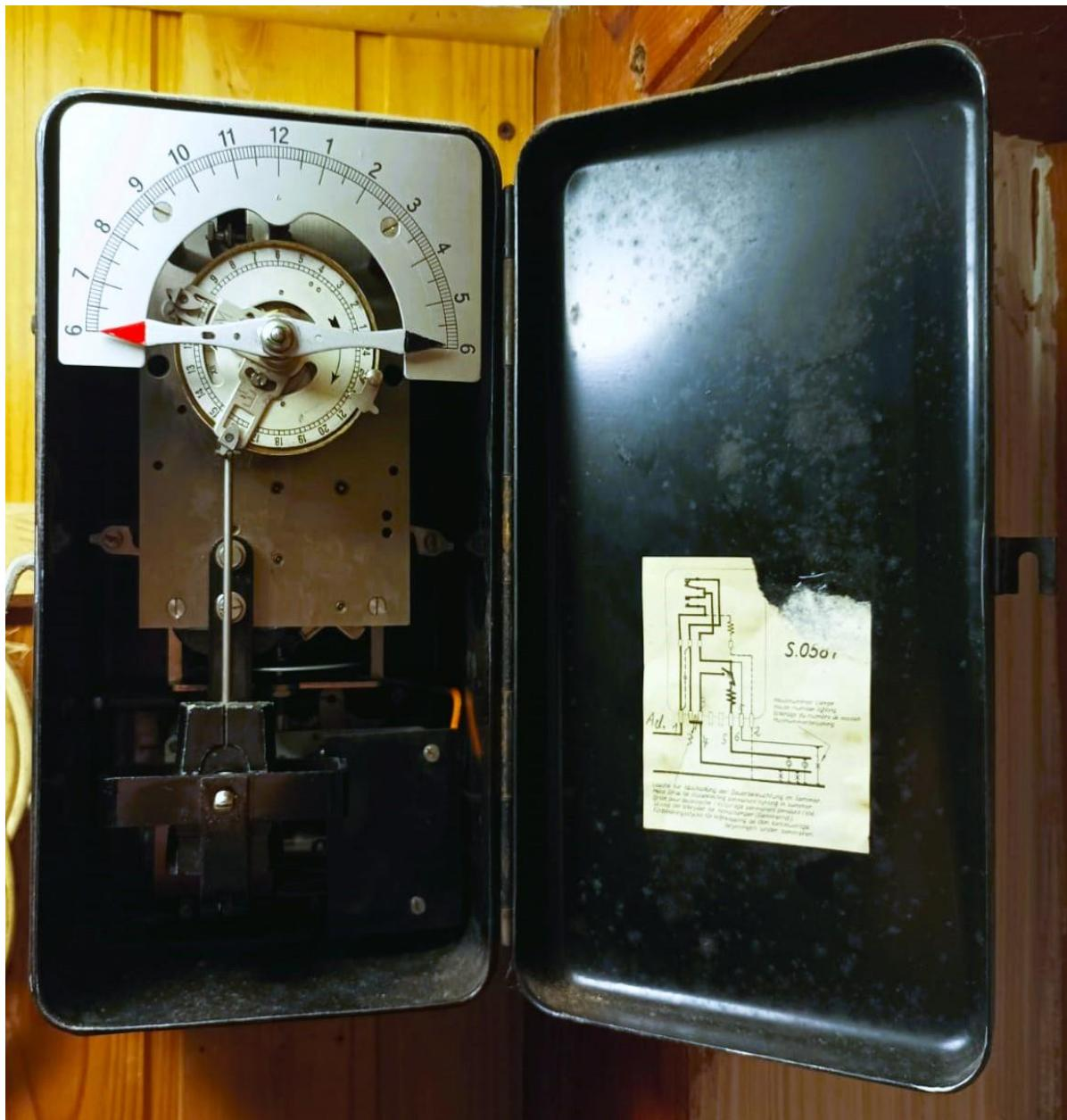
Es handelt sich um eine selbstaufziehende, elektro-mechanische astronomische Schaltuhr mit eingebautem Treppenlicht-Automaten.
