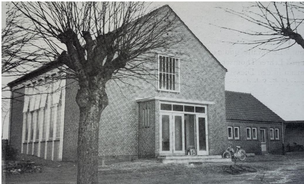
Neubau der Turnhalle
